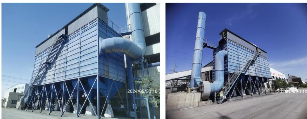
每两台矿热还原炉设置一套废气除尘器
