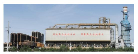
1-6台矿热还原炉废气输送至除尘器管道
