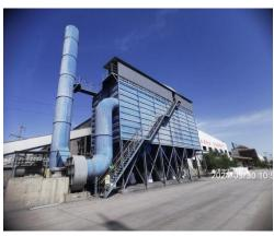
每两台矿热还原炉设置一套废气除尘器
