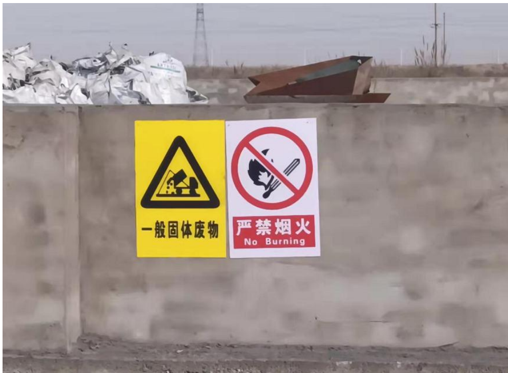
一般固废储存池
