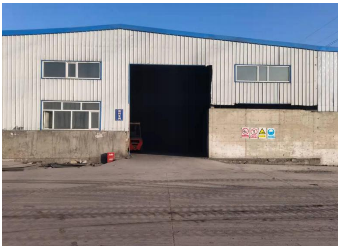
封闭式原料库房
