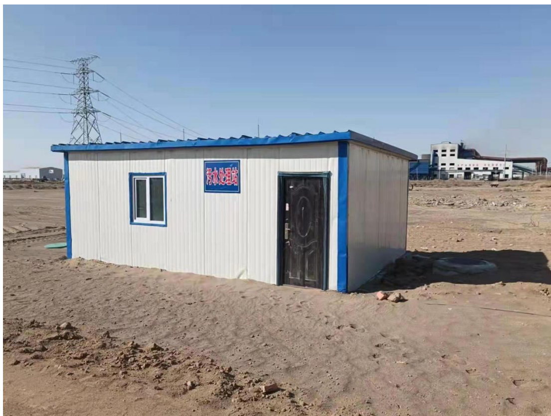
厂区生活污水处理站
